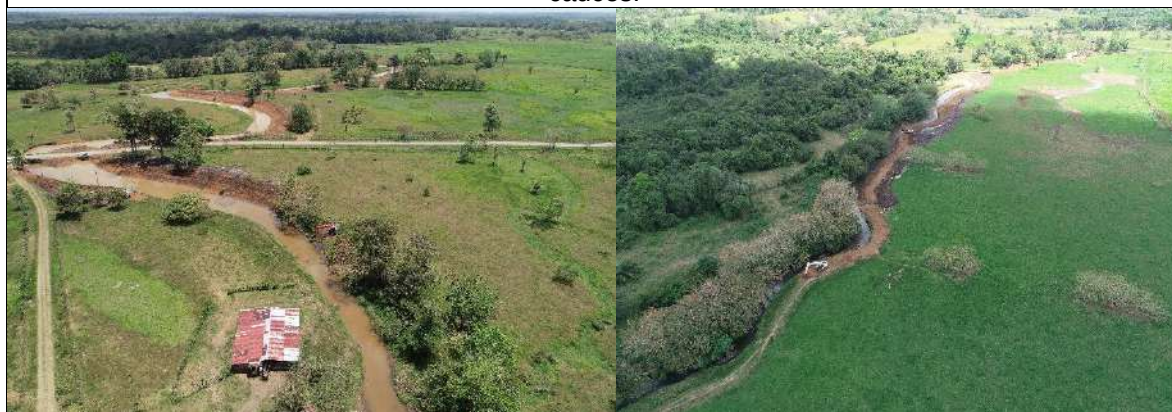
Figura 5: intervenciones en el río Samén y Aguas Negras.
