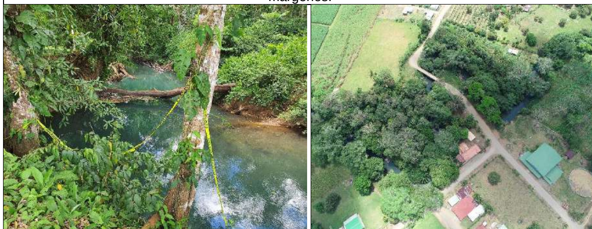
Figura 7: escombros desviando el caudal y generando erosión lateral sobre las márgenes.
