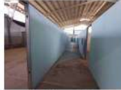
Figura 4. Avance de la obra
