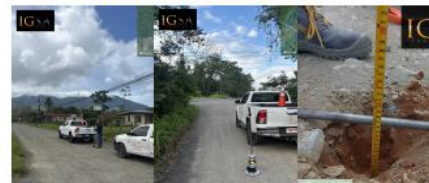
Trabajos preliminares de laboratorio para la ruta 164
