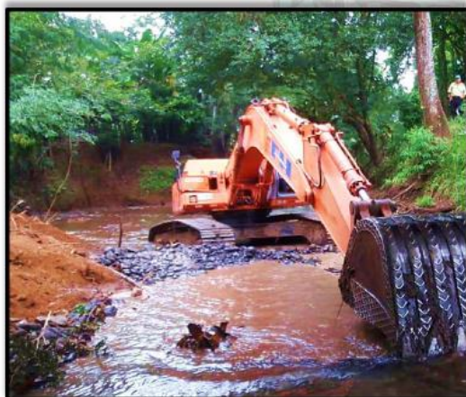
Excavadora limpiando el cauce del río Pataste
