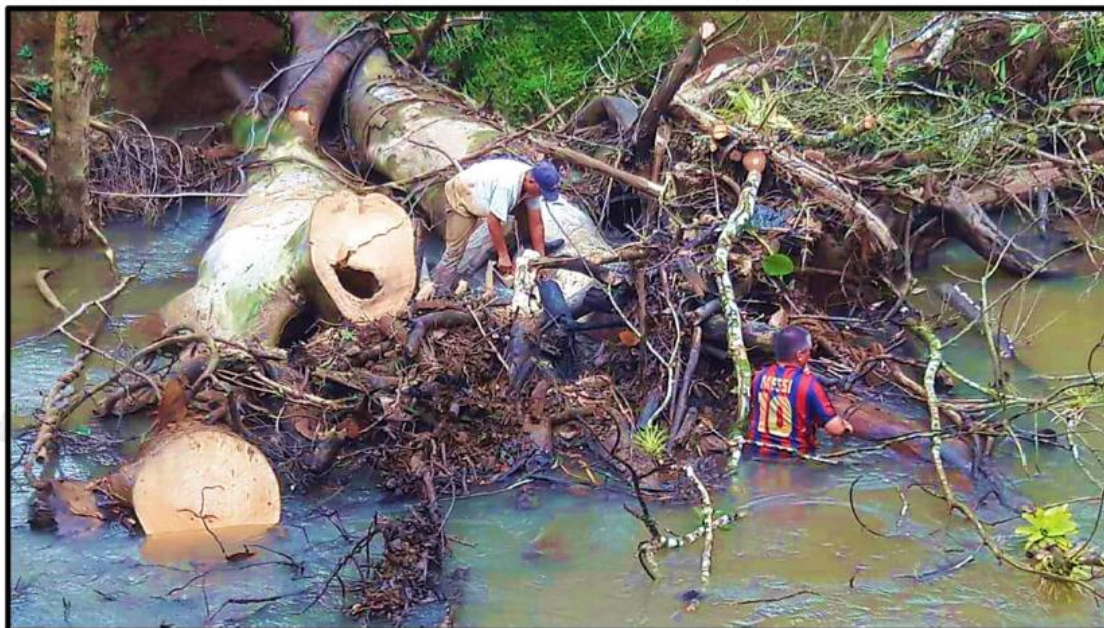
Foto que muestra el estado del río Pataste antes de la intervención. Miembros de la comunidad cooperaron con la corta de los escombros para facilitar su extracción.
